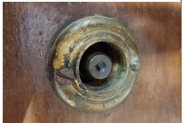
Figure 113 : Insert en alliage cuivreux pour la manivelle. État proche de l'original, les vis ne sont pas similaires.
