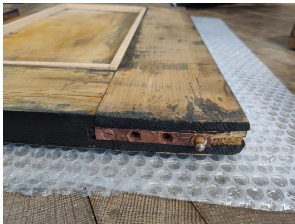
Figure 78 : Corrosion des charnières des portes.
