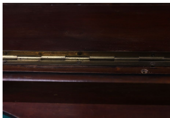
Figure 103 : La charnière est dans un bon état de conservation.
