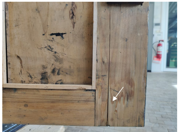
Figure 73 : Porte avant fendue.
